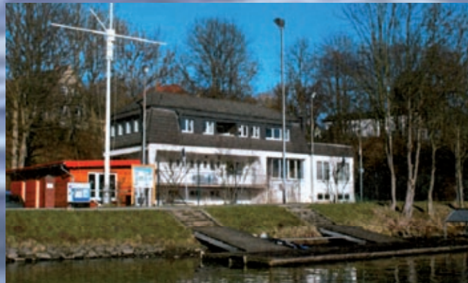
Clubhaus „Am Obergraben“
